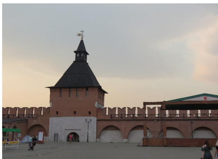
Башня водяных ворот (Водяная башня) (фото А. Сергеевко)
